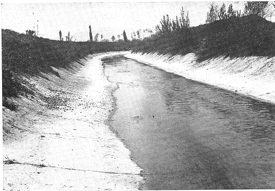
Fot. 27 — F.so Anquillara. Panoramica del letto in cemento.
